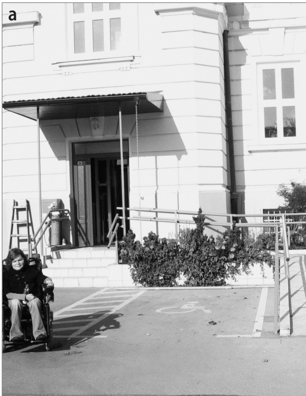
Slika 7: (a) Dostopen stranski vhod za osebe na invalidskih vozičkih z urejeno klančino; (b) Dolžina, naklon, vmesni podest ter določila za ograjo pri klančini morajo upoštevati zakonodajni okvir, da je klančina primerna za samostojno uporabo oseb na invalidskem vozičku. Primer, kjer določila niso upoštevana.
