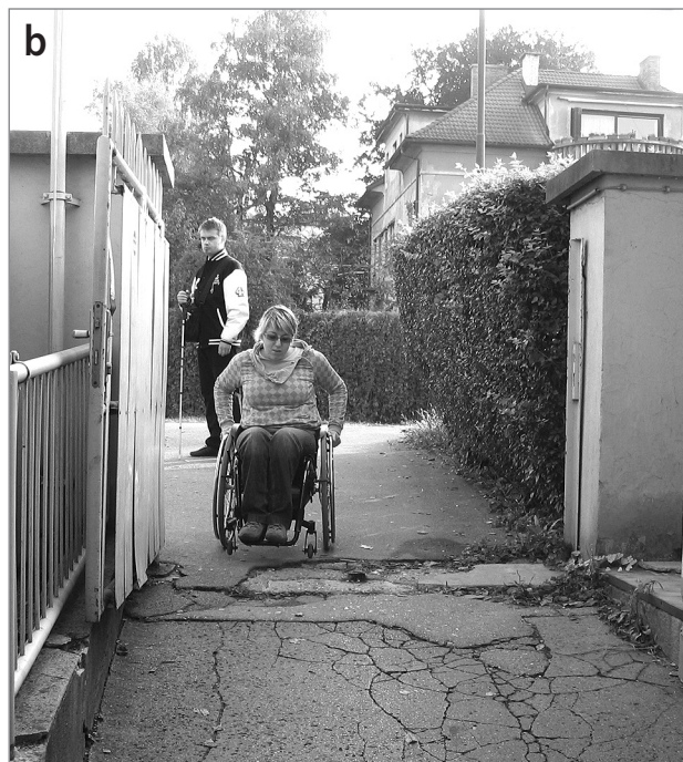
Slika 5: (a) Kljub blagemu nagibu je nujno potrebno, da je klancina vsakih 6 m prekinjena z 1,5 m dolgim podestom, le tako jo povprečni uporabnik na vozičku lahko samostojno uporabi; (b) nevdrževana klancina na dostopni poti.
