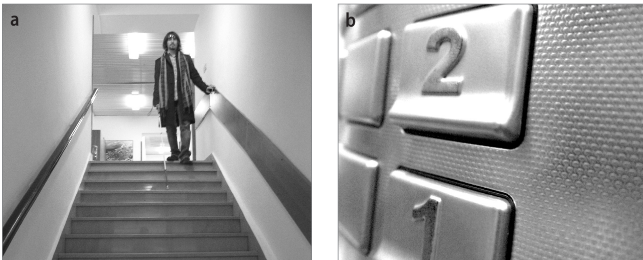
Slika 14: (a) Primer stopnišča, ki je primerno opremljeno z držali; (b) primer reliefnih gumbov na stikalni plošči v dvigalu.
